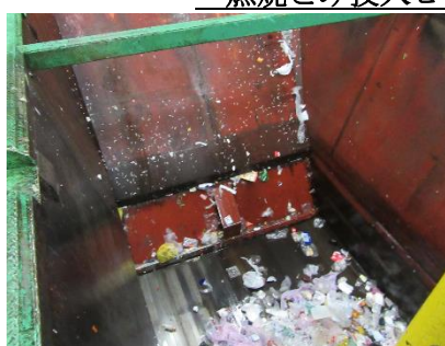
__ 燃焼ごみ投入ビット(一階)
